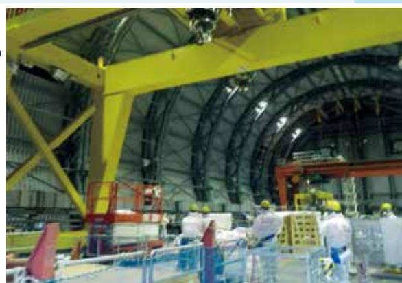
3号機オペレーティングフロア
