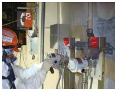
原子炉建屋内計器点検
