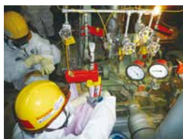
冷却水用ポンプの点検
