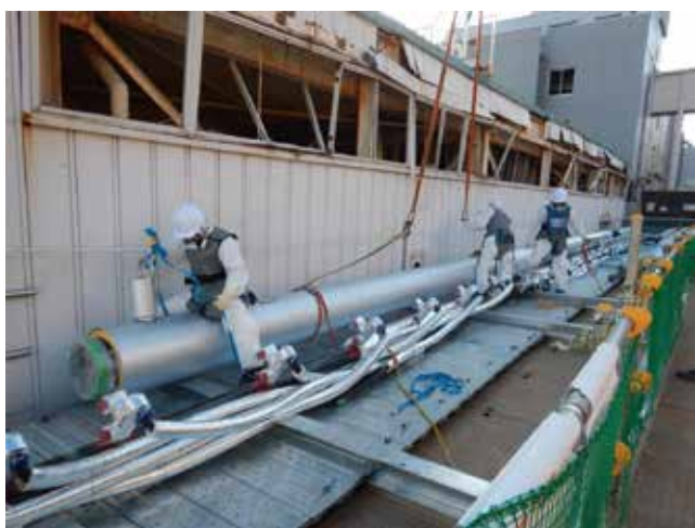
凍結管の設置工事
