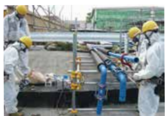
冷却水用配管の設置
