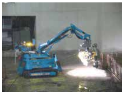
2号機オペフロ内残置物移動・片付け
